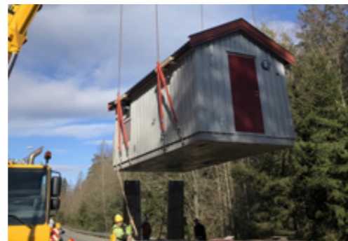
Intecs pumpestasjoner prefabrikeres ferdig og kan etterpå bare heises på plass på anlegget.
