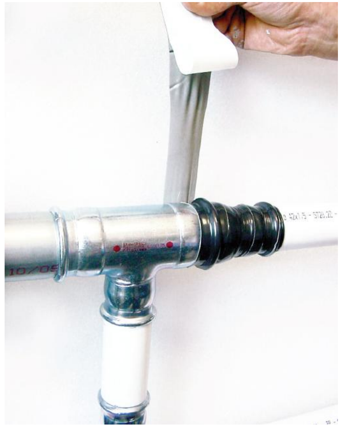
Bilde 38 – Beskyttelse av koblingene med butanoltape.
