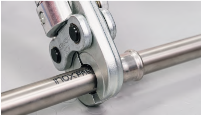
Bilde 32 - Utfør presskoblingen
