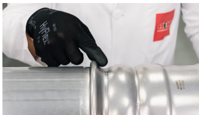
Bilde 36 – Visuell inspeksjon av Oversize-pressing
