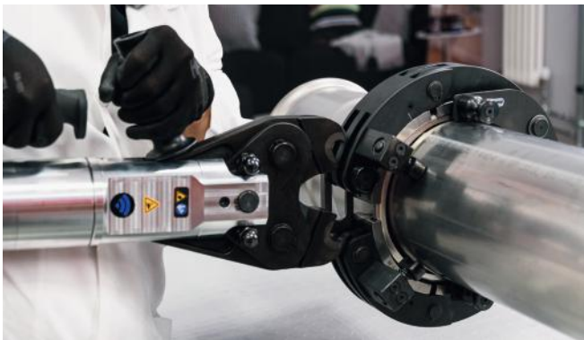
Bilde 34 - Montering av press, 1. fase
