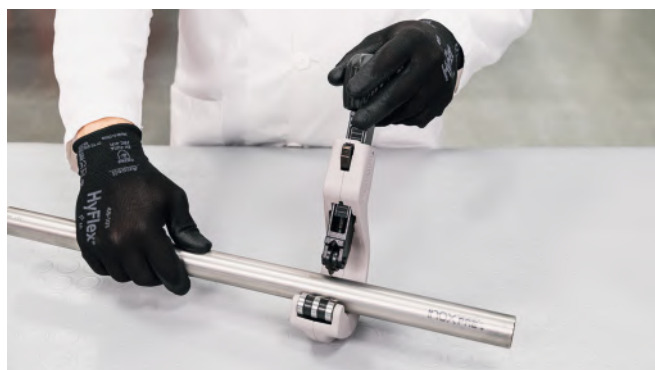
Bilde 25 - Tilkutting av rør
