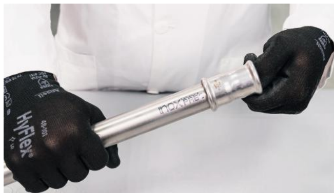
Bilde 31 - Sett røret inn i pressfittingen
