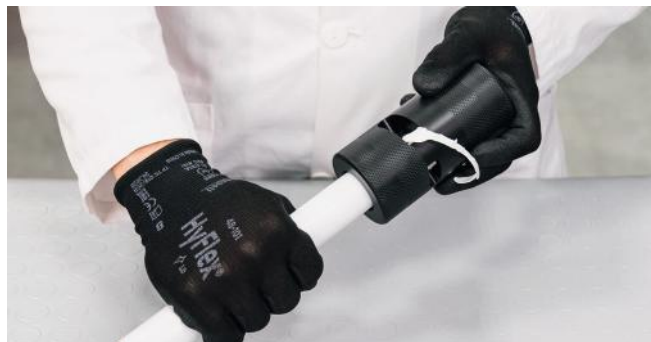
Bilde 29 - Stripping (steelPRES PP-belagt)
